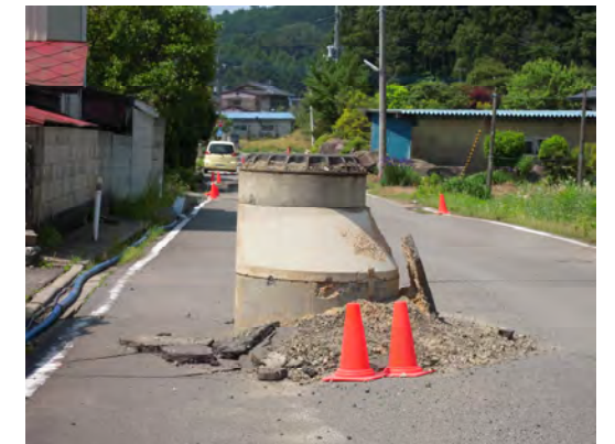
液状化によるマンホールの浮き上がり (平成 23 年 3 月：西郷村)
