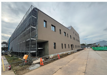
▲ 外壁塗装工事完了部分
