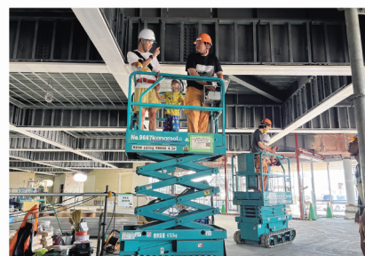
▲ 高所作業車体験
