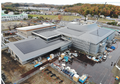
▲ 令和7年10月末時点施工状況
