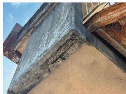
▲ 鉄筋膨張による爆裂
