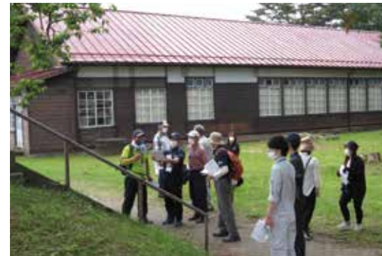
昭和10年に建てられた歴史民俗資料館
