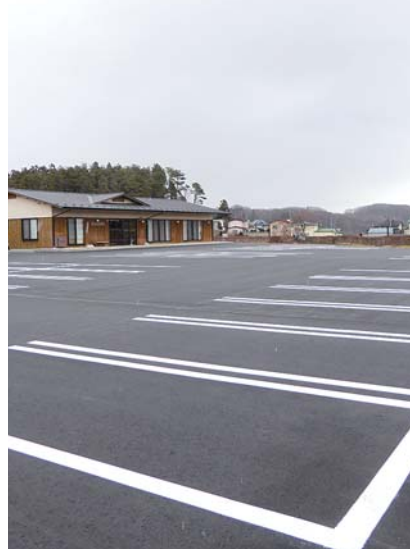
▲特定防衛施設周辺整備調整交付金を活用して整備した(上)村道大平中線、(下)熊倉コミュニティセンター駐車場
