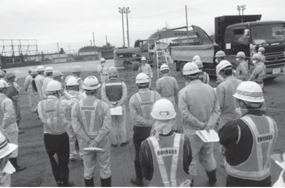
▲大型土のうの積み込み講習の様子
