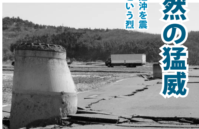
▲羽太地区 液状化現象に伴うマンホールの隆起
