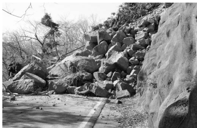
▲真名子付近の土砂崩れ
