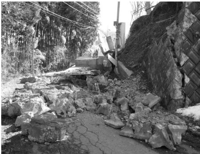
▲勝負沢付近 土砂崩れ
