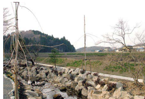
▲熊倉地区のほ場整備事業も着々と進んでいます
