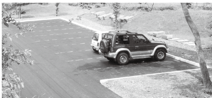
▲新設された駐車場
