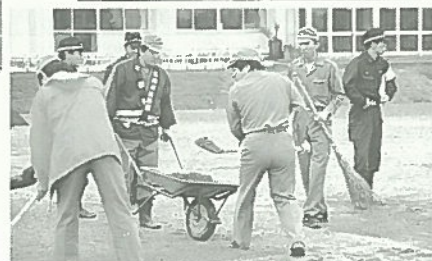
△足場を整備する消防団幹部のみなさん。
