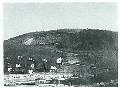
温泉健康センターの敷地造成工事
