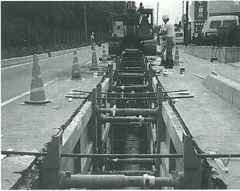
▲中央幹線築造状況(下新田地区)
