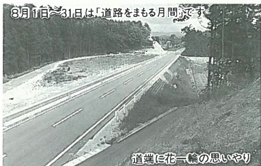
道路は人が歩き、車が行き交うといった交通のためばかりでなく、電線や電話線、ガス管、上・下水道などの収容スペースとしても、大きな役割を果たしています。8月は「道路をまもる月間」です。道路にやさしく、思いやりを！
