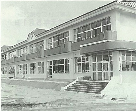
①鉄筋コンクリート 2 階建 面積=1,109.8㎡ ②133,000千円 ※簡易保険還元融資施設
