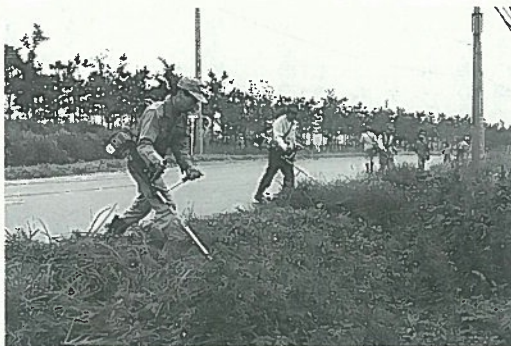
▲草刈機を使用しての作業(芝原地内)
