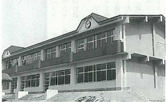
①建築工・本体 鉄筋コンクリート造2階建(一部平家建) 建築面積 845㎡ 床面積 1530.4㎡ 基礎 鉄筋コンクリート独立基礎 PHC.SC杭打 ・機械室 鉄筋コンクリート造平家建 面積=50.49㎡ ・受水槽室 補強コンクリートブロック造 面積=33.41㎡ ・吸排気風道 5.285㎡ ②261,761千円
