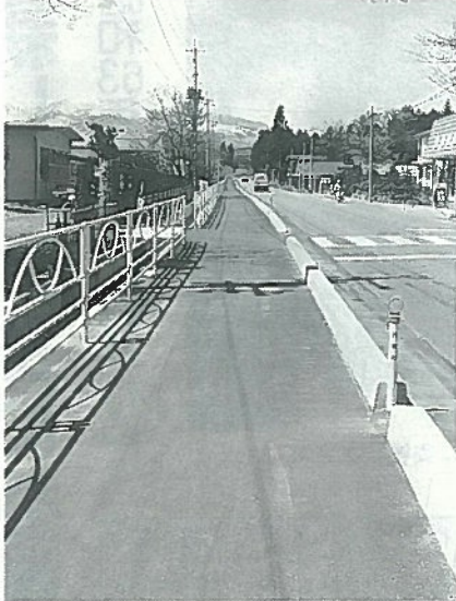
①自転車、歩行者用道路アスファルト舗装 延長=720.0m 幅=2.0m ②36,262千円
