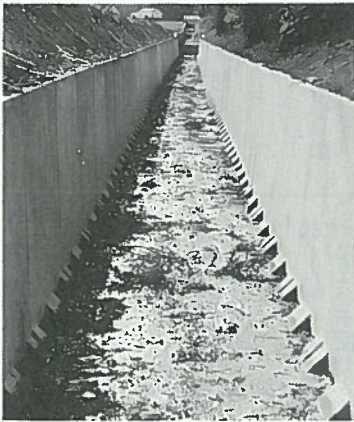
①幅1.50×高さ1.20m 延長610.0m ②29,846千円
