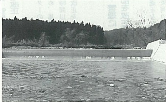
①コンクリート固定堰 延長32.0m ②35,983千円
