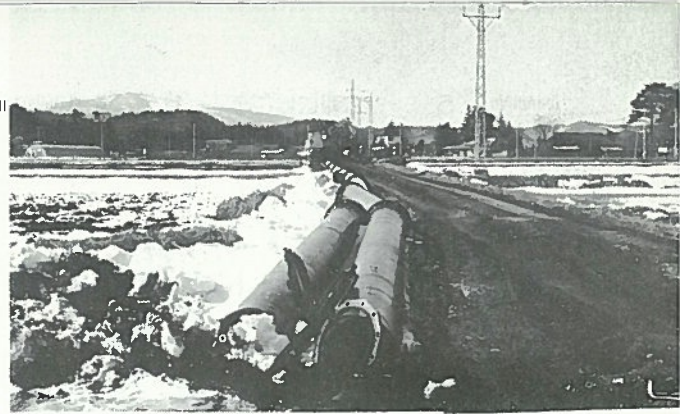
▲配水管布設工事 (真船地内) ダクタイル鑄鉄管 (径400mm) 1606m 区間の布設状況
