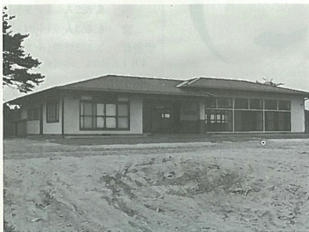
▲充実された研修施設 (一の又地区)
