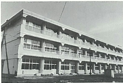
完成した新校舎(第一期工事)
