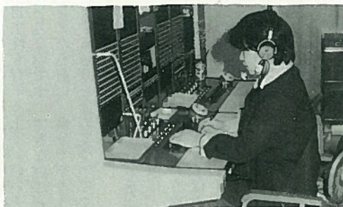
新装になった有線放送電話室
