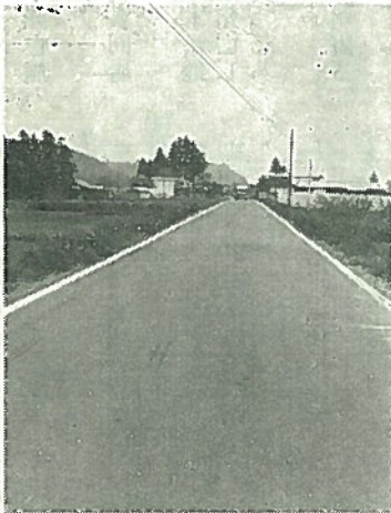
非補助事業 村道米熊倉線舗装 27,477千円 ▼ L=2,670m W=6.5m
