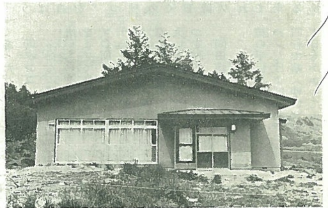
由井ヶ公民館 (木造平屋建てモルタル造り) 3,565千円 133㎡ ▼
