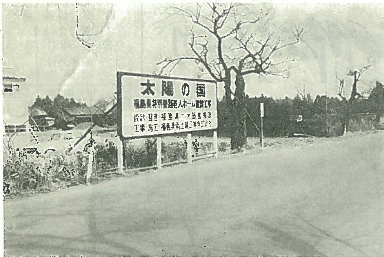
〔上野原に建設中の特別老人ホーム予定地〕
