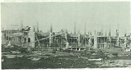
〔写真〕 八月完成を目指して進行中の役場新庁舎建設現場
