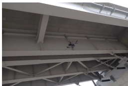
ドローンによる桁下の点検
