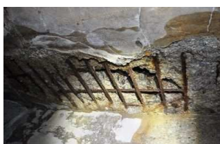
補修前 右：損傷（鉄筋露出）
